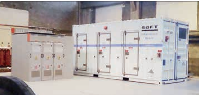
6 Armarios de baterías del ESS y del convertidor en una instalación de Filadelfia, PA, Estados Unidos
